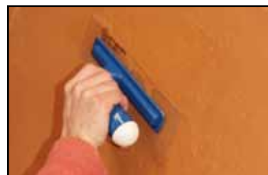
Étape 4 - à mi séchage, resserrer l'enduit à l'aide d'une spatule plastique souple.
